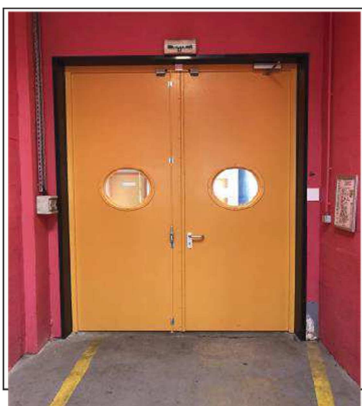
Porte d'entrée vue intérieure
