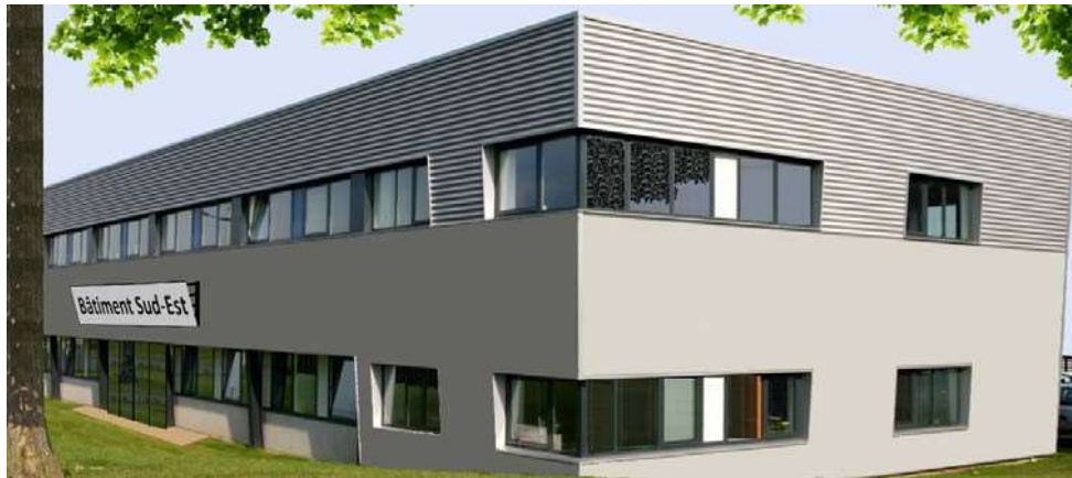
Bâtiment Sud-Est (SE) de la pépinière
