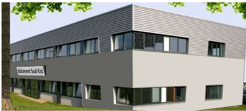
Bâtiment Sud-Est (SE) de la pépinière
